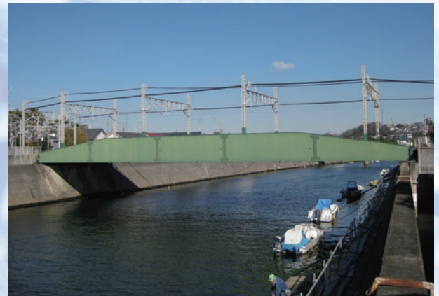
小田急電鉄・境川橋梁(神奈川県藤沢市)
