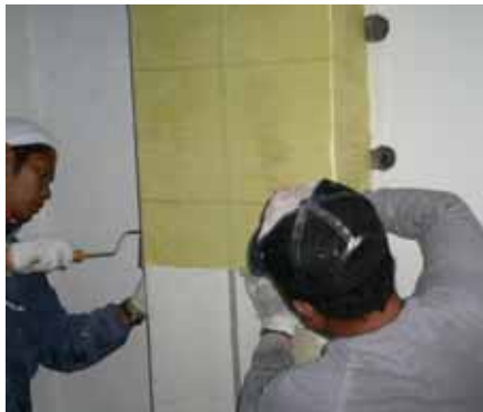
カバーシート貼付け
