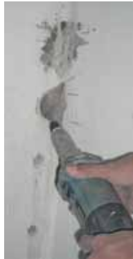
柱側の面処理
