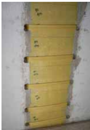
カバーシート・帯シート取付け完了
