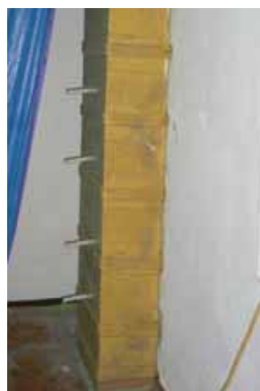
カバーシート・帯シート取付け完了
