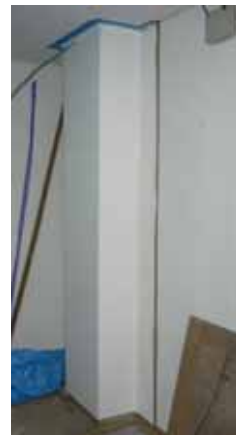
仕上げ塗装完了
