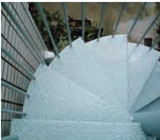
マンション縞鋼板外部階段
