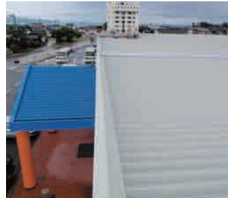
新潟県佐渡 折板屋根塗替え塗装工事
