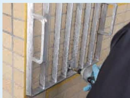
③ PDフレーム固定孔を穿孔してフレームを取り付けます。
