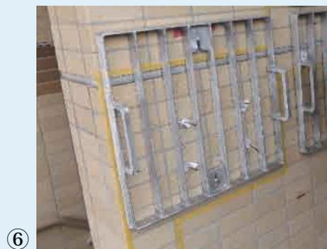
⑥ 注入孔に栓をして樹脂の戻りを抑え注入圧を維持します。
