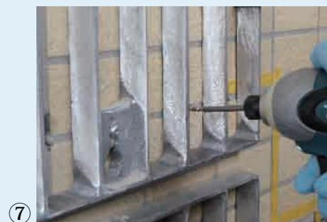
⑦ 樹脂が落ち着いたら PD ピン又は全ネジ切りボルトを挿入します。
